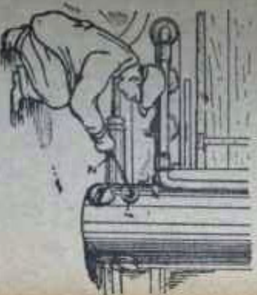
Joonis 79. Gaasivõlvikambri õhuvässi põlemise kontrollimine. 1 — õhuvässi, 2 — toru.
