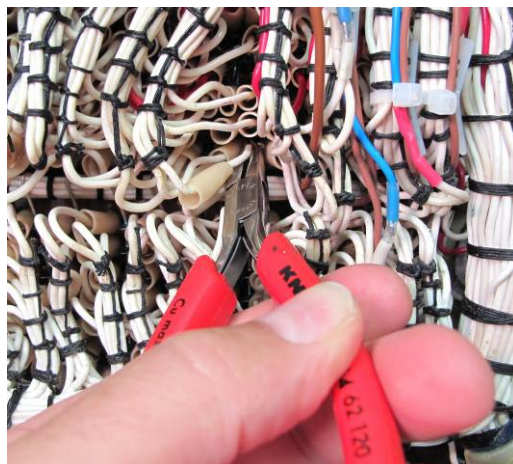
Abbildung 80: eines der beiden Kabel durchknipsen
